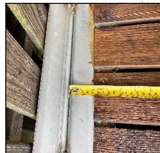
建物現況測量、梁柱丈量
