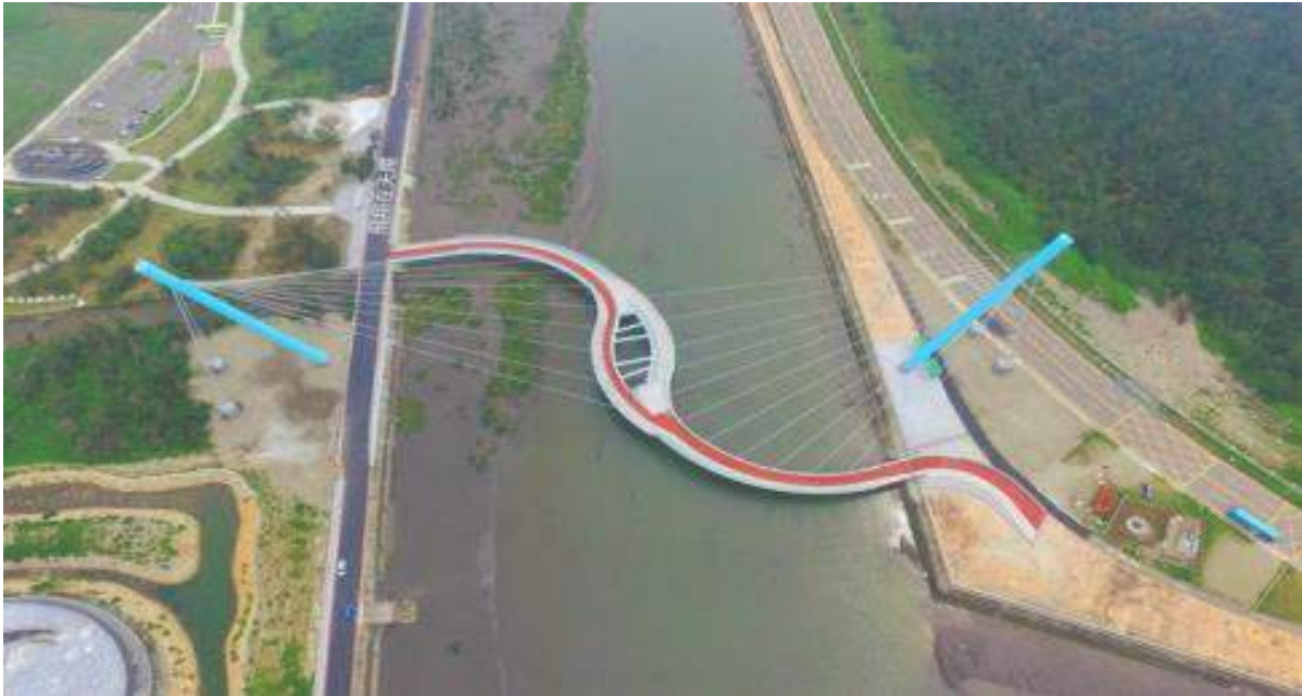
圖 1-5 景觀橋暨海堤路景觀美化改善工程
