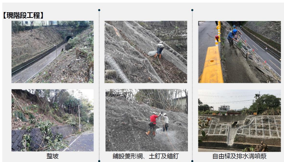
圖 3-7 工程施工照片
