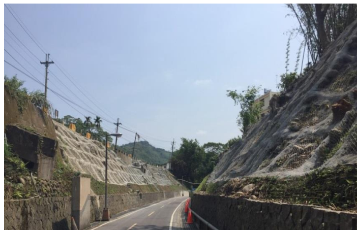
圖 5-2 工區現況相片
