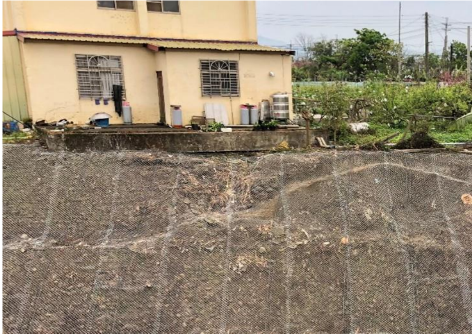
圖 3-6 工區南側邊坡上方緊鄰民宅
